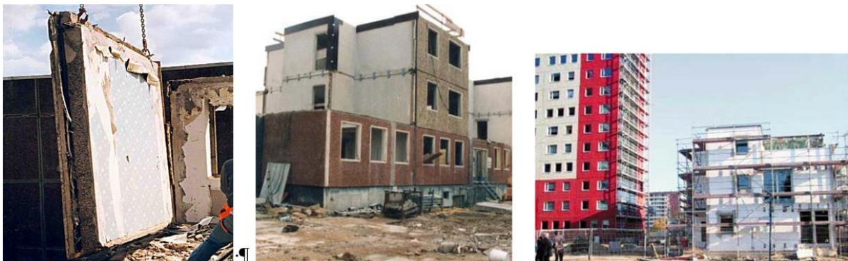
Abbildung 4: Kontrollierter Rückbau ermöglicht neuen Aufbau des gebrauchten Bauteils ohne Qualitätsverlust
